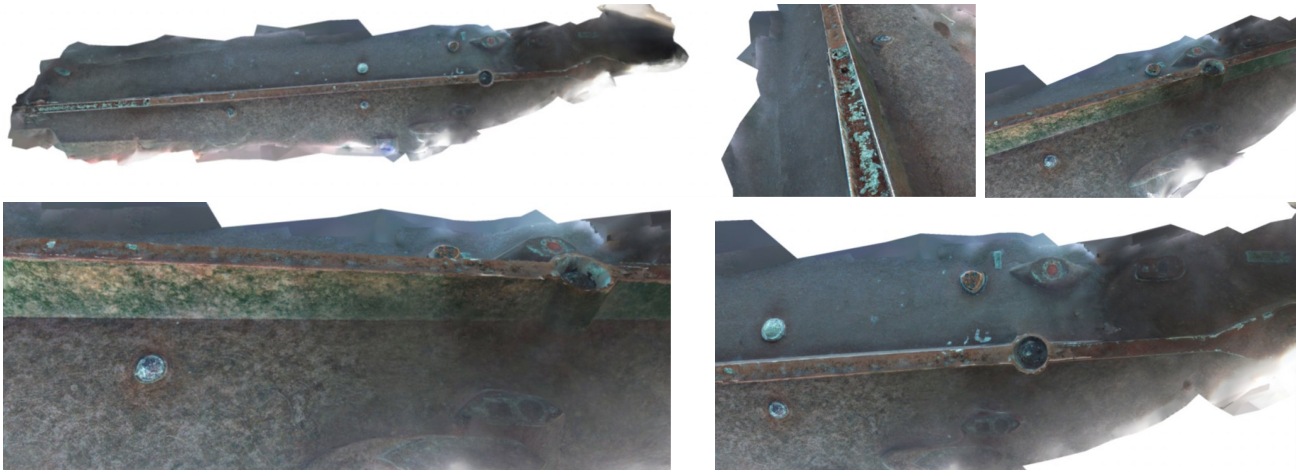
Diversas vistas de la reconstrucción 3D obtenidas mediante el sistema autónomo de inspección desarrollado por IQUA Robotics
